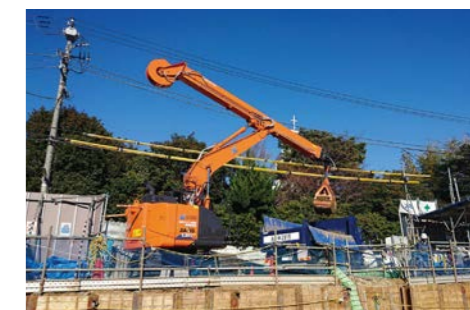
■ 発生土の積み込み作業
