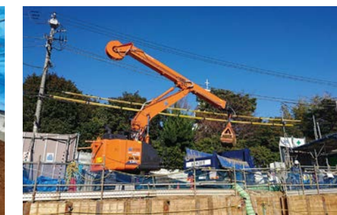
■発生土の積み込み作業
